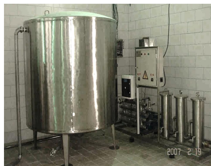
مخزن پیش تصفیه و سامانه چهارردیفه تابش اشعه ماوراء بنفش همراه بوسترپمپ و سیلندرهای میکروفیلتر
